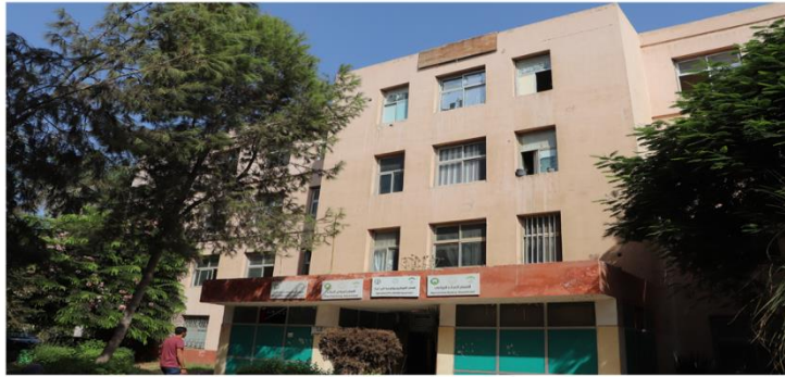
مبنى النبات الزراعي
